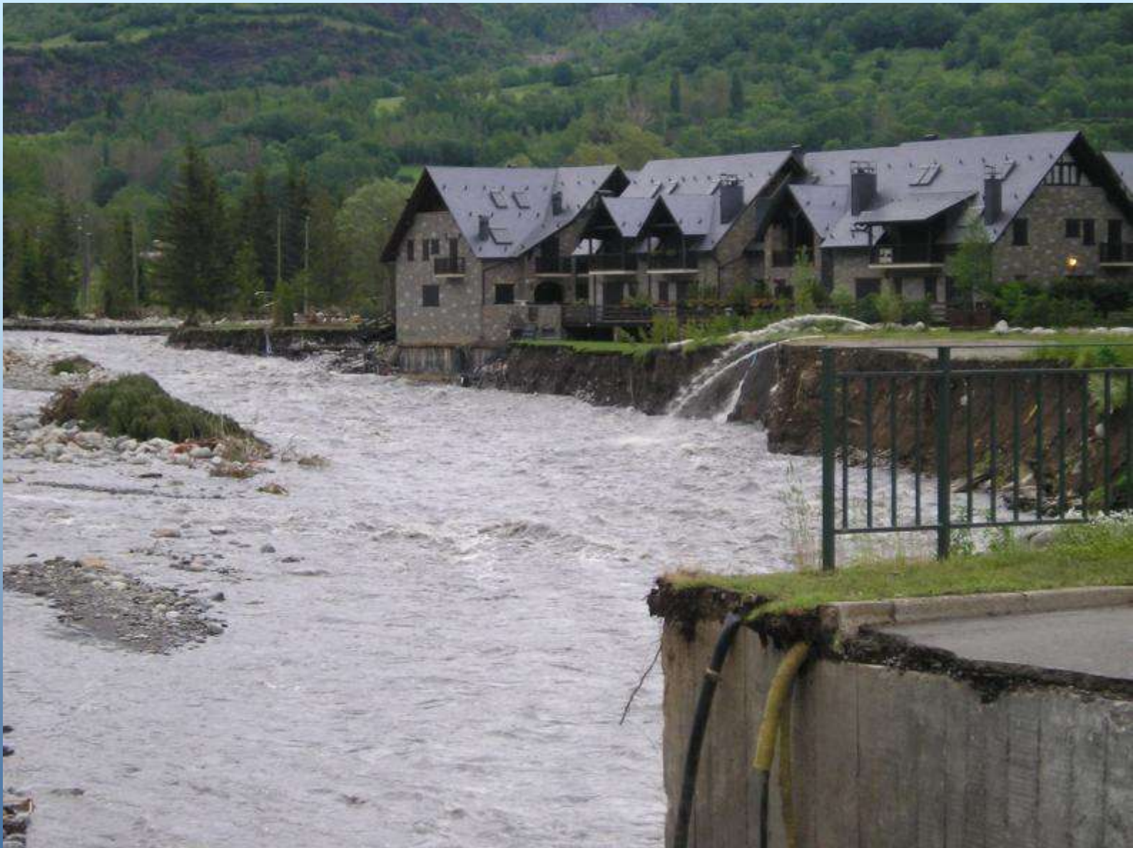
Aguas arriba del Puente de Linsoles Después de la avenida
