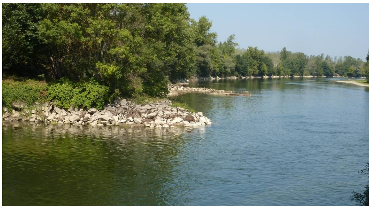
Enrochement de berges de Garonne
