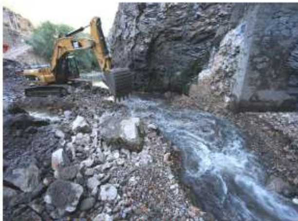
Retirada de escombros
