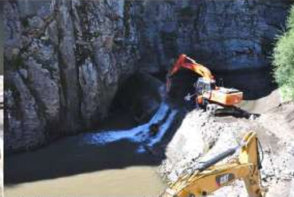
Inicio de la demolición del muro
