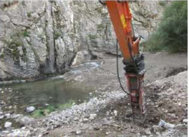
Finalización de los trabajos
