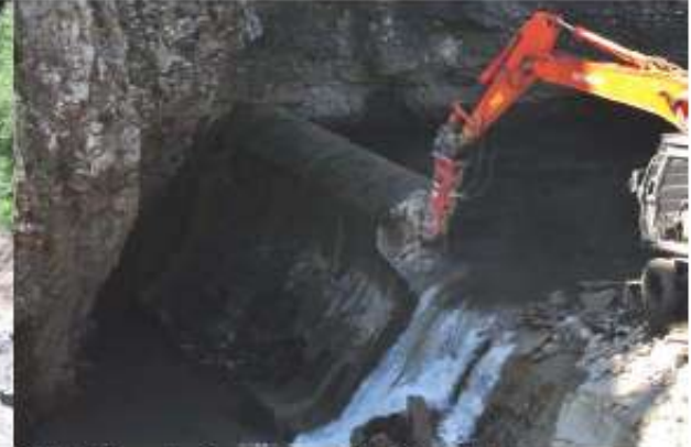
Detalle de la demolición del muro
