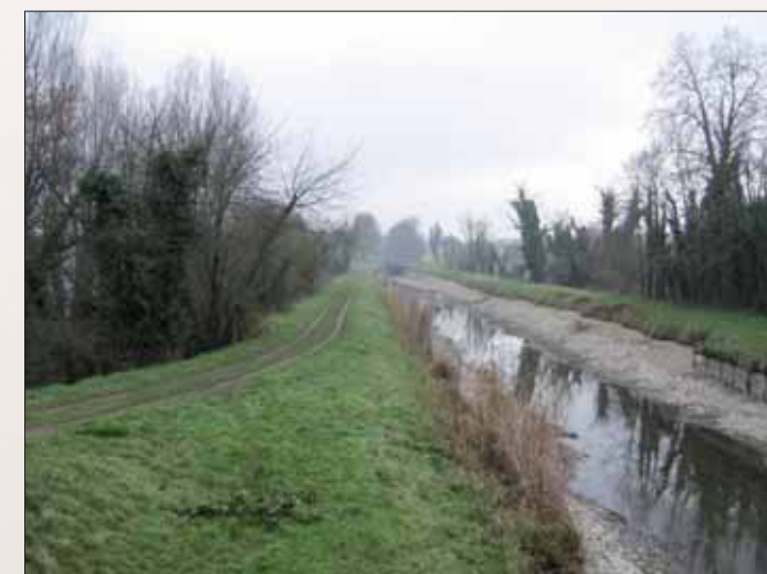
La double barrière visuelle composée de la ripisylve et de la digue interdit toute relation entre les deux voies d'eau.
