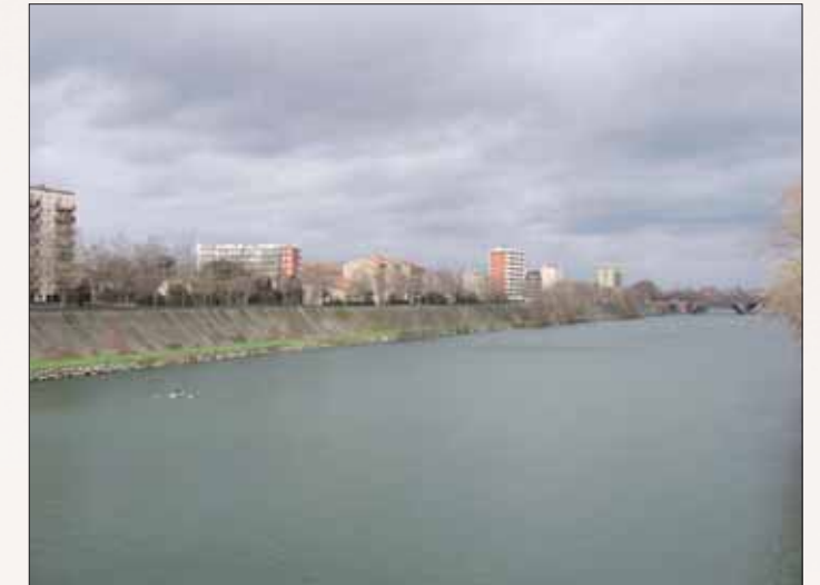
Les digues impactent fortement le paysage urbain toulousain par l'uniformité de leur volume et de leur nature, en béton.
