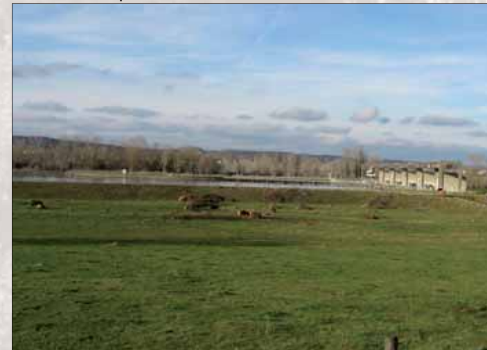
Du Plan d'Arem à Carbone, les barrages ponctuent le cours du fleuve et se repèrent facilement grâce à l'architecture très rythmée des édicules qui se juxtaposent sur l'ouvrage de retenue.
