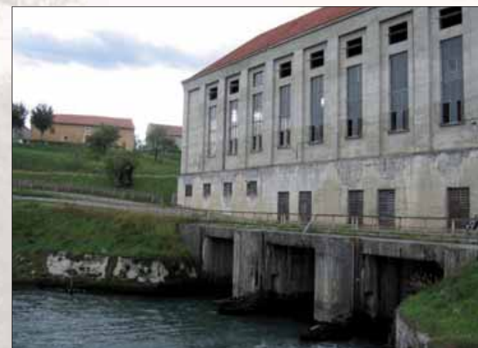
La centrale de Taillebourg : les façades austères en pierre caractérisent les bâtiments industriels de la première moitié du XX ème siècle.
