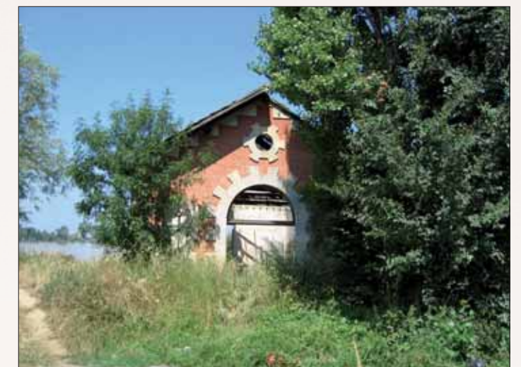
Cet édicule anciennement associé à la gestion d'un canal à Saint-Louis-Montferand fera bientôt l'objet d'une restauration. Mais bien trop souvent, le petit patrimoine est oublié et laissé à l'abandon.
