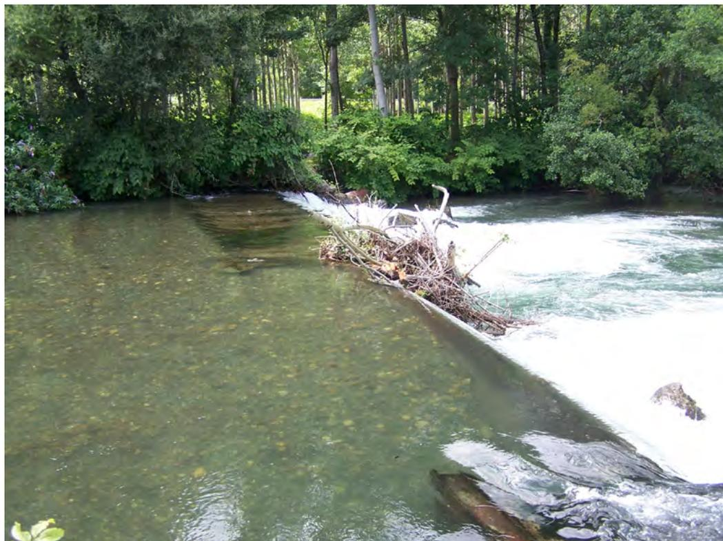
Afin de connaître les débits écoulés à cet endroit, il est nécessaire d'établir une correspondance entre la hauteur mesurée et le débit du cours d'eau. Cette courbe de tarage (relation du débit en fonction de la hauteur d'eau) est construite en effectuant des mesures ponctuelles de débit, pour différents niveaux d'eau de la rivière.
