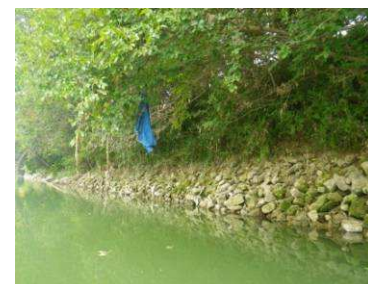
Enrochements sur berges - T.PICHILLOU-BIOTOPE © (photo prise sur site)
