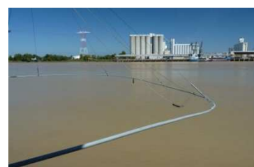
Centrale thermique au Bec d'Ambès - T.PICHILLOU-BIOTOPE © (photo prise sur site)
