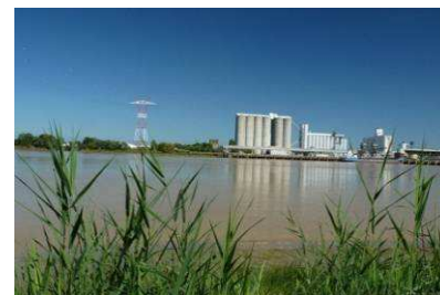
Terminal céréalier de BASSENS-T. PICHILLOU-BIOTOPE® (photo prise sur site)
