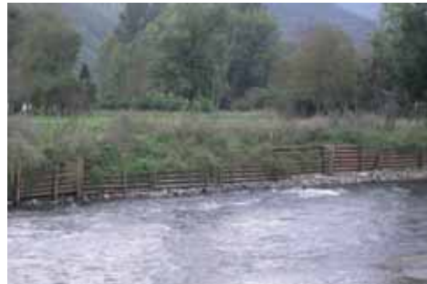
Caissons réalisés à Fronsac
