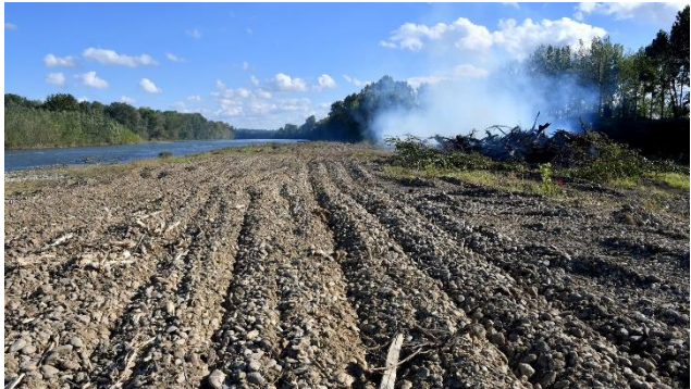
Fin de la phase 1 avec scarification de l'atterrissement et brulage sur site des souches
